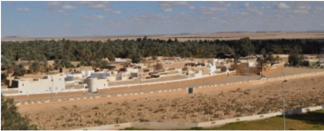
صورة (5) توضح السور الجنوبي الخارجي لمدينة غدامس القديمة مصدر الصورة (الأستاذ إبراهيم مالك )
